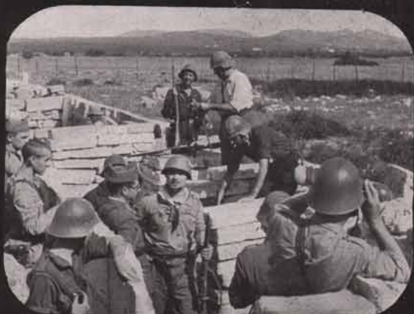
... E MENTRE SORVEGLIA LA COSTRUZIONE DI TRINCEE
